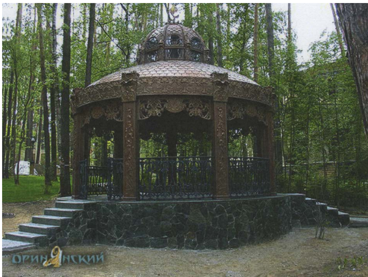
Рис. 19. Облицовка беседки «под бронзу»
